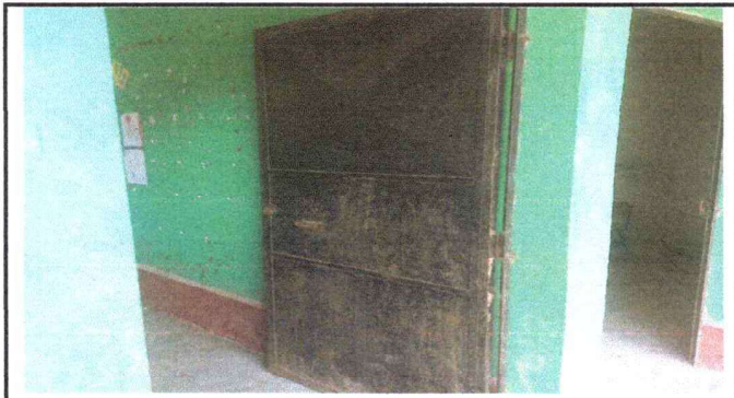
Foto 3: Cambio de dos puertas por deterioro
