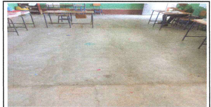
Foto 4: Cambio de piso por agrietamiento a piso cerámico
