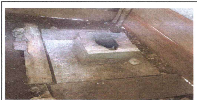
Foto 5: Reparación de fosa séptica
